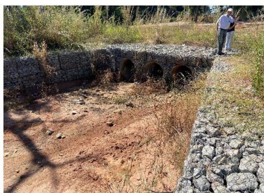
*Descarga da rede de drenagem em 3 tubos de 600mm*
