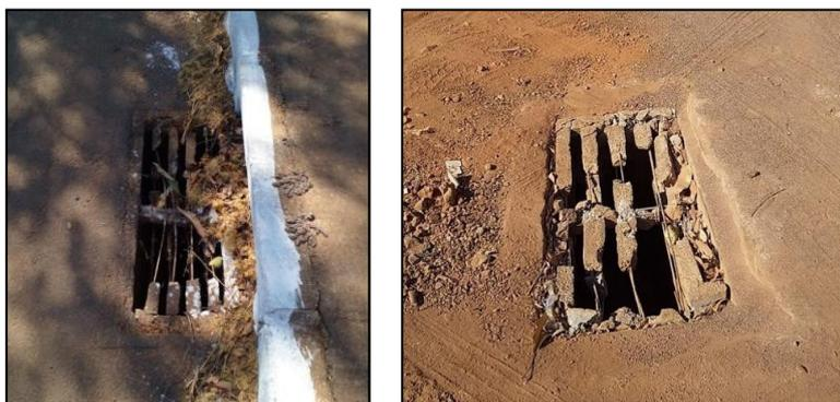
**Figura 2-L: Grelhas quebradas devido às cargas do tráfego sobre elas**
