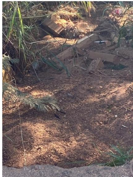
*Vista à jusante – colapso do pavimento/calçamento – nota-se o carreamento dos blocos das guias*
