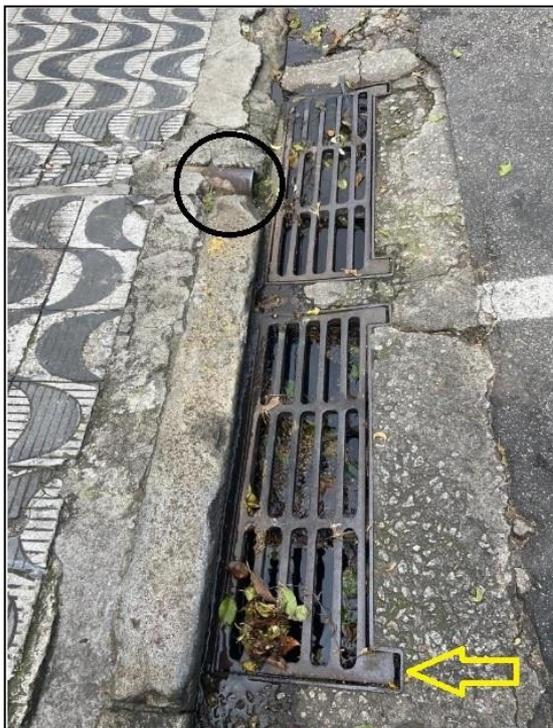
**Figura 3-XXIV: Tubulação de descarga na Boca de Lobo e Grelhas de ferro fundido, articuladas- São Paulo, SP**
