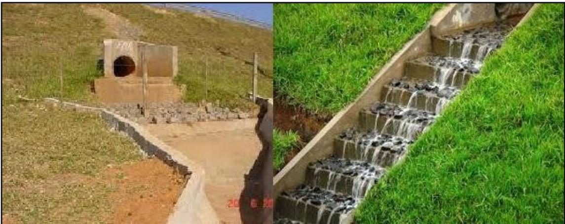
**Figura 3-XIX: Exemplos de degraus e escadas de dissipação**
