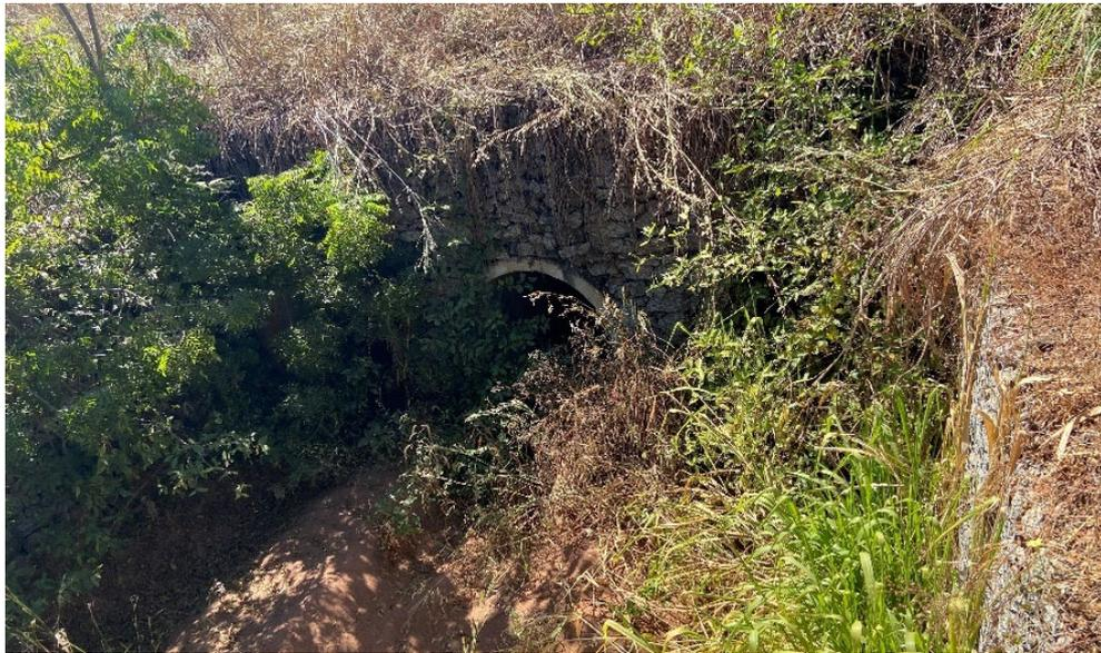
*Desemboque da rede de drenagem (3 tubos de 600mm), parcialmente obstruído*
