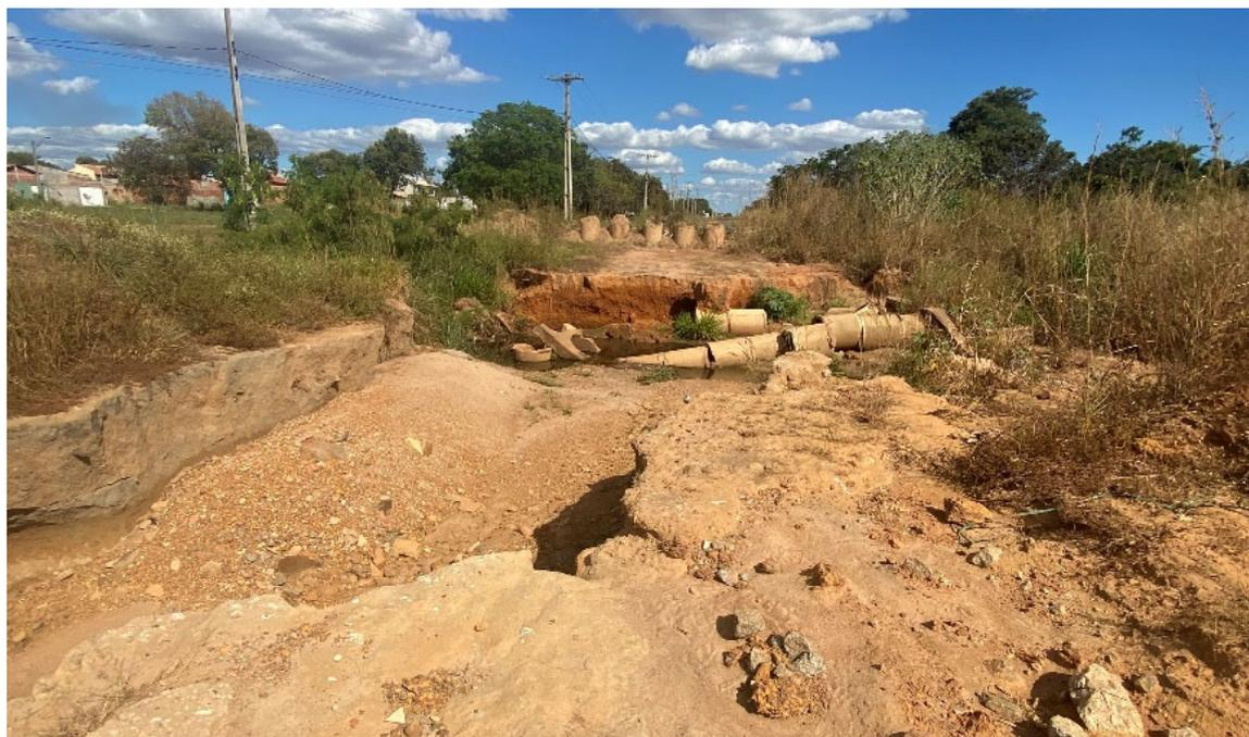
*Erosão na via pública com tubulação colapsada*
