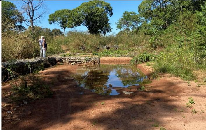
*Retenção de água devido à significativo acúmulo de “areia fina” ao longo da estrutura*
