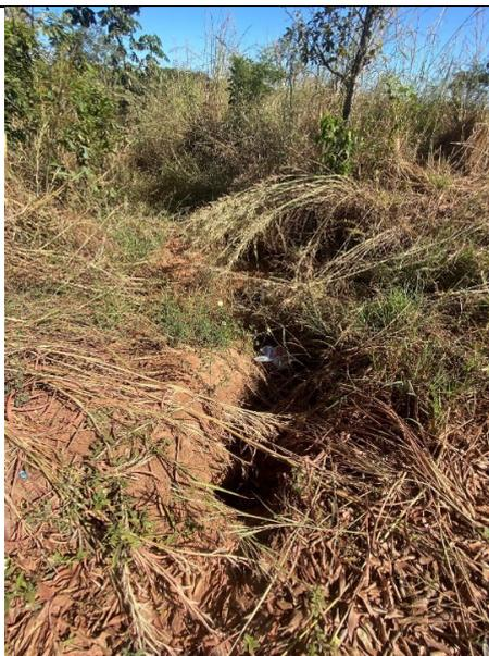
*Jusante da tubulação de passagem obstruída: apenas vertimento de águas superficiais e muitos detritos*
