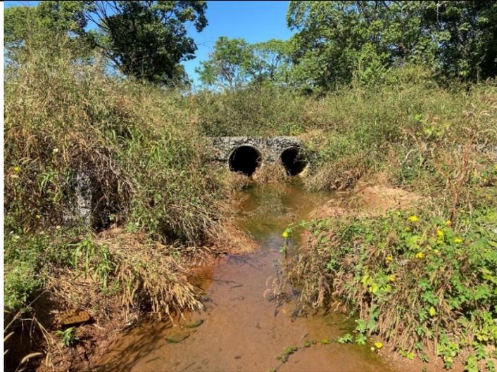
*Descarga em 2 tubos de 600mm - assoreamento e infestação vegetal – necessário limpeza e manutenção*
