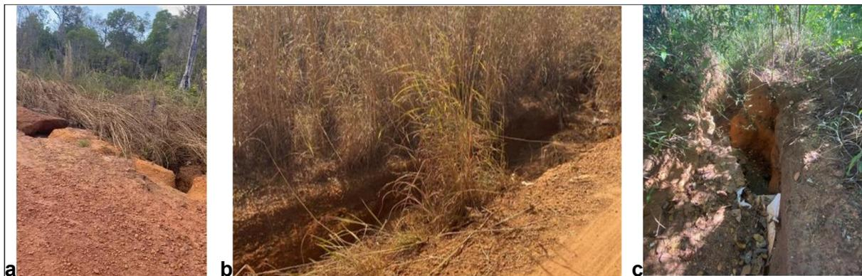
**Figura 2-XXXVIII: Processos erosivos por escoamento superficial (a. Machado, b. Taquari, c. Taquaruçu Grande) ocasionados por ausência, ou funcionamento inadequado, de estruturas e dispositivos de drenagem – Atualização 2022**
