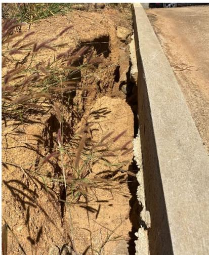
*Problemas de erosão do solo adjacente à estrutura do extravasor superficial*
