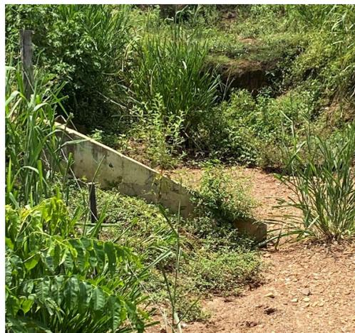
*Emboque da tubulação de drenagem, observa-se assoreamento.*
