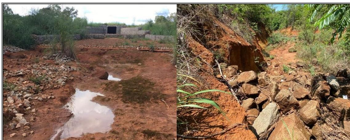
**Figura 2-XXXIX: Processos erosivos por entalhamento do terreno, à jusante de estruturas de drenagem (Sussuapara)**
