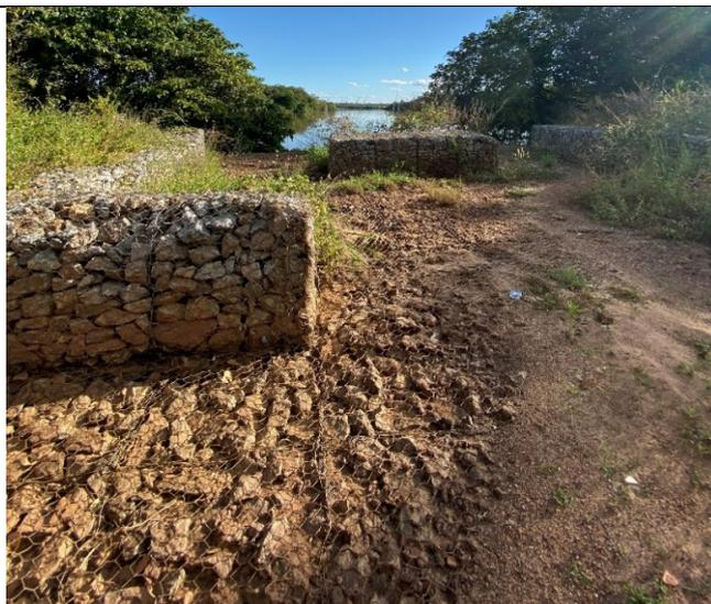
*Observa-se assoreamento pela diminuição da velocidade de escoamento no desague direto no Ribeirão Taquaruçu*
