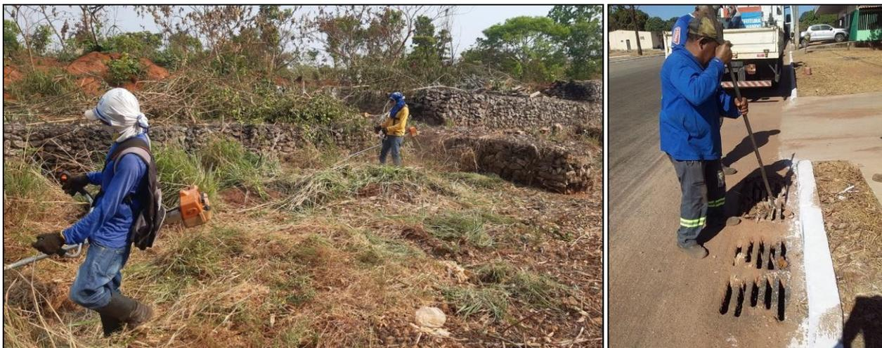
**Figura 2-LII: Supressão da vegetação (roçagem) e desobstrução de bocas de lobo**
