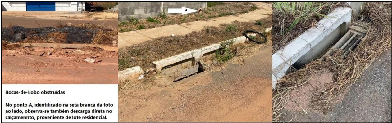
**Figura 2-XLV: Exemplos de Bocas-de-Lobo obstruídas**
