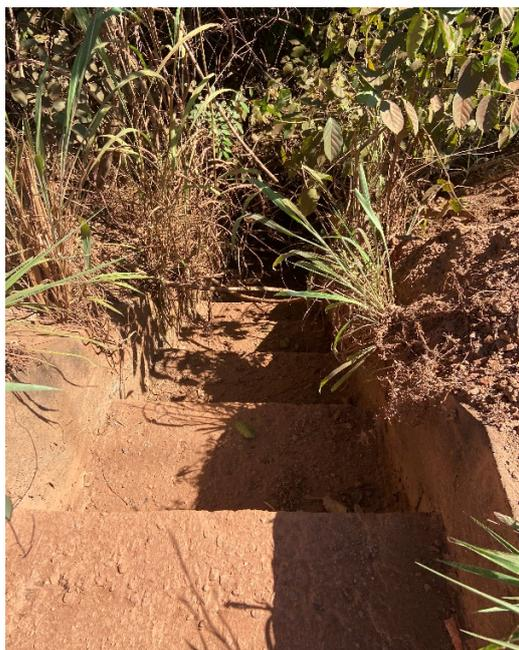
*Descarga superficial em escada, para dissipação de energia*
