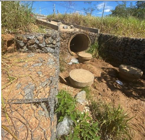
*A descarga do desemboque da rede -tubo de 1500mm- ocorre em estrutura de transição de gabiões*
