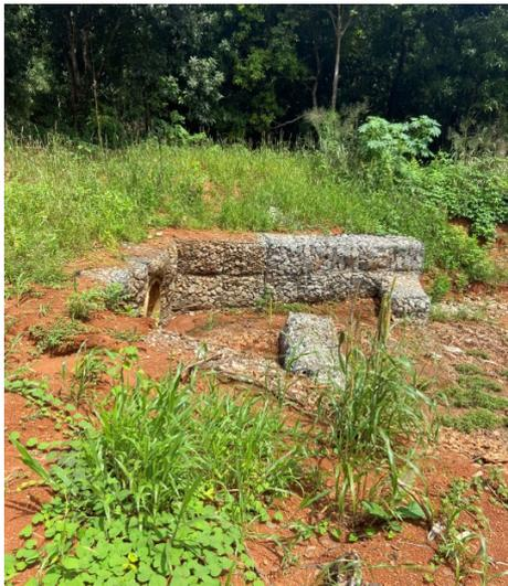
*Dispositivo de lançamento com estrutura de Gabiões*
