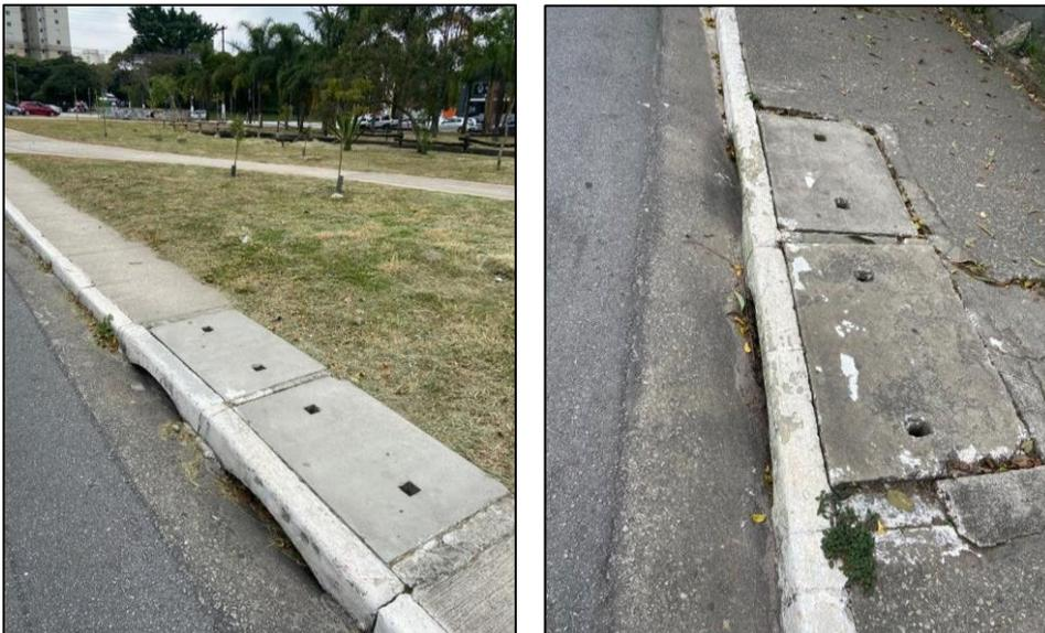
**Figura 3-XXVII: Bocas de lobo de Guia combinadas (2), com depressão, e caixa de inspeção na calçada – Córrego Zavuvus, São Paulo/SP**
