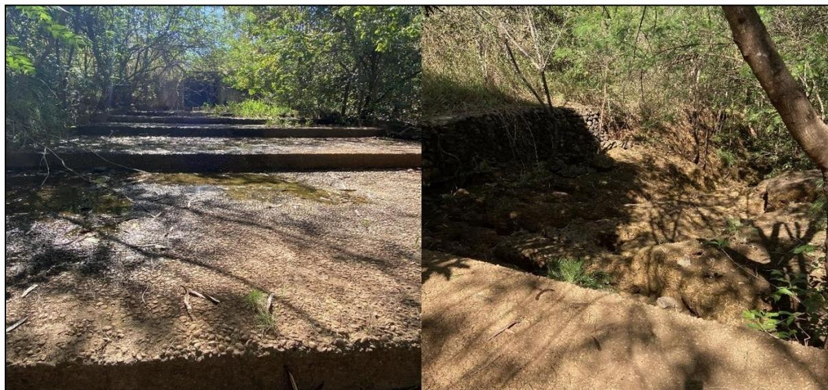
**Condição em 2022: significativo adensamento da vegetação e carreamento completo do enrocamento que existia à jusante**
