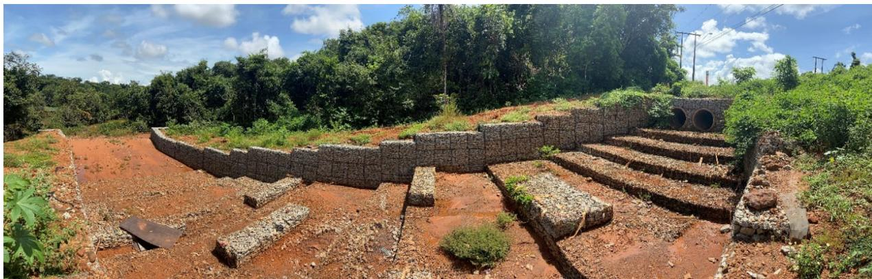
*Vista Panorâmica do Ponto de Lançamento – observa-se deposição de sedimentos, entulho, perda de material dos gabiões e vegetação a ser removida, para evitar obstruções.*
