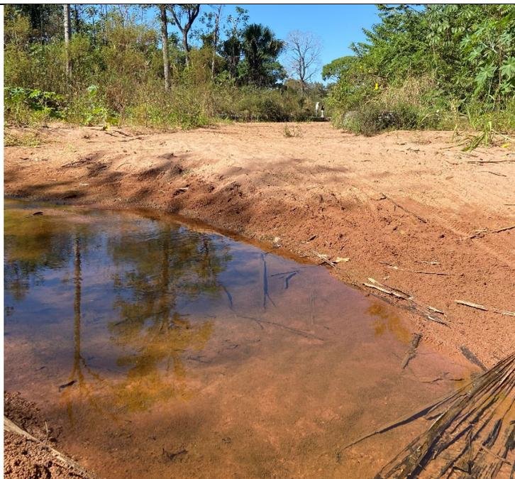
*Vista para montante da estrutura, onde a sedimentação "areia fina" resultante do assoreamento caracteriza a porção final do ponto de lançamento da rede de drenagem.*
