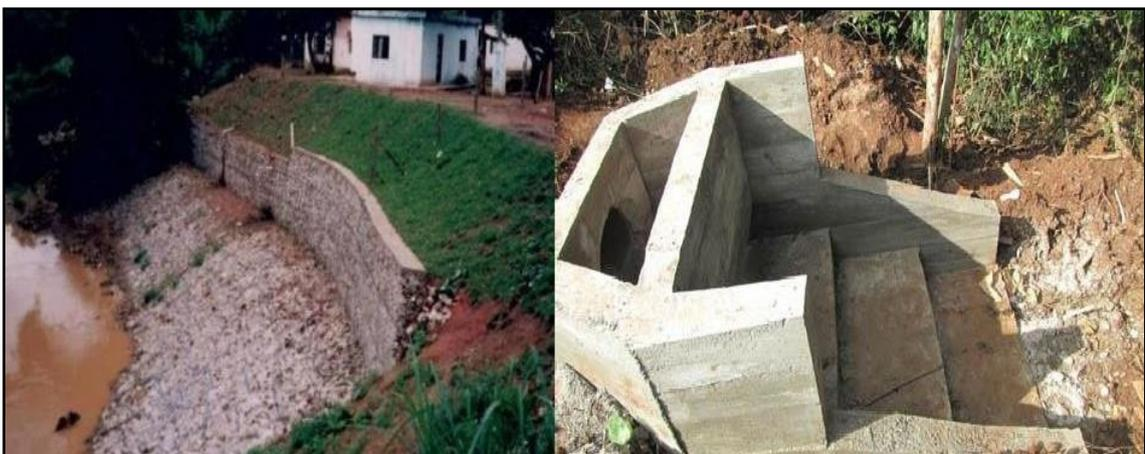
**Figura 3-XX: Exemplos de proteção de margens e escada de dissipação**
