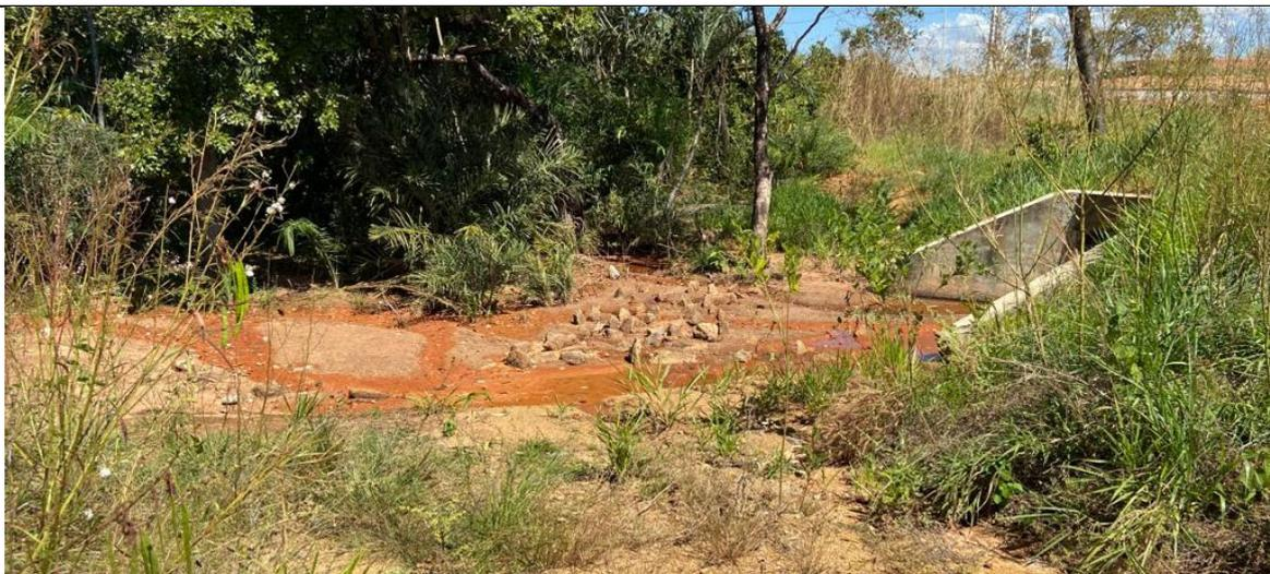
*Vista geral do lançamento de rede – aparente tendência à carreamento de sólidos, dissipação de energia ineficaz*
