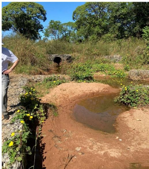
*Intenso acúmulo sedimentar devido à assoreamento na estrutura - efeito é esperado, mas requer dragagem e limpeza*
