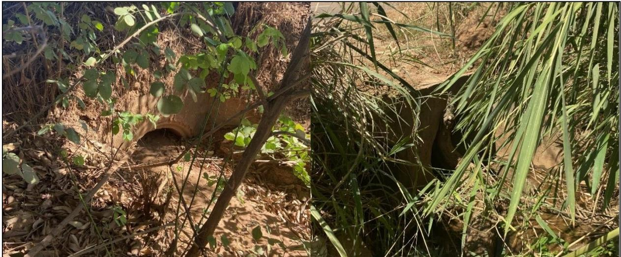
**Figura 2-XLVI: Tubulações de passagem com seção reduzida, com comprometimento quase total do funcionamento**
