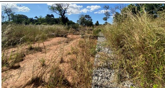
*Assoreamento denota baixa velocidade de escoamento – acúmulo de sedimentos propicia crescimento de vegetação*
