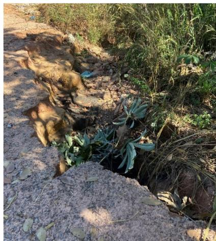
*Pavimento colapsado na aproximação do local onde a rede de drenagem desemboca – não há guias nem calçamento*
