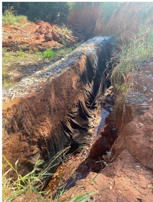
*Processo de forte erosão adjacente à ala do dispositivo*
