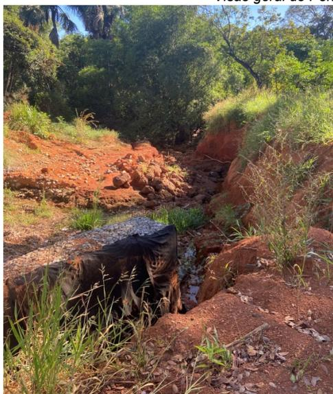
*Erosão e Ravinamento em torno da estrutura*
