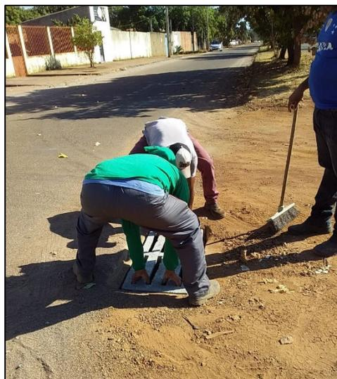
*Boca de lobo mal posicionada, em intersecção de vias, fora da sarjeta/meio-fio: constante necessidade de substituição devido à ruptura gradada pelo tráfego de automóveis.*
