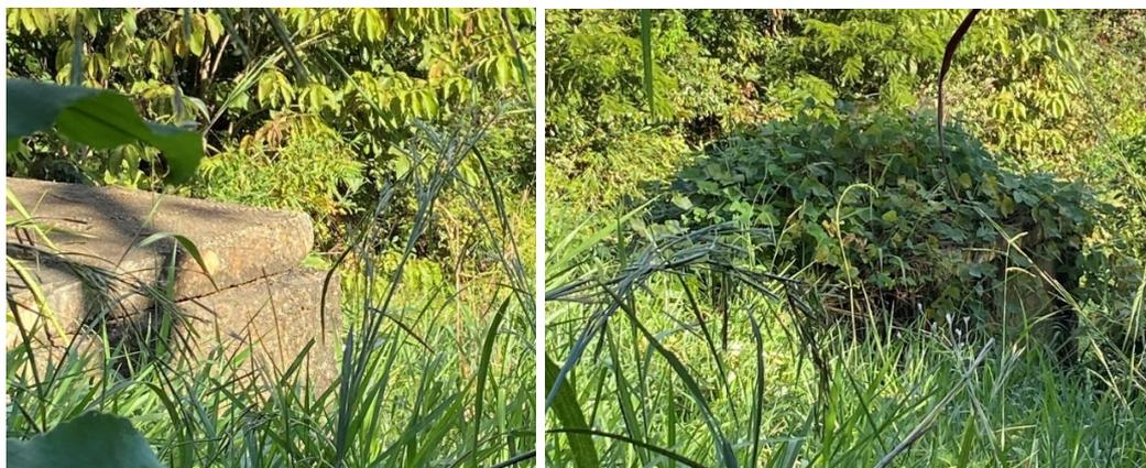
*Caixas de passagem e inspeção infestadas por vegetação - localizadas antes da descarga da rede, que não está acessível*
